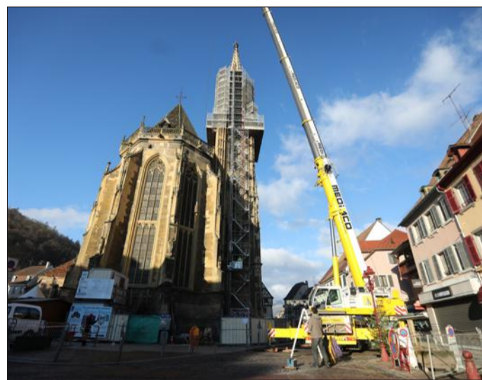
Une impressionnante grue a permis de hisser les gargouilles jusqu'au clocher. Des travaux qui ont causé quelques embouteillages à Thann et alentours. Photo L'Alsace
