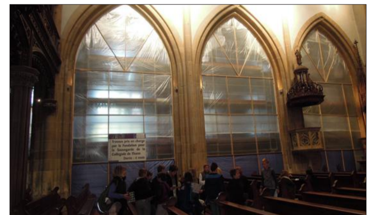
Le bas-côté nord, en travaux, est fermé au public jusqu'à la mi-novembre.
