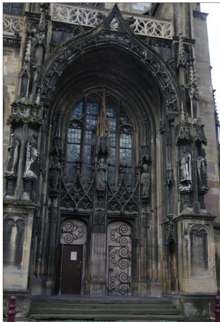
Le portail nord sera au cœur des travaux prévus fin 2016 à début 2017.
